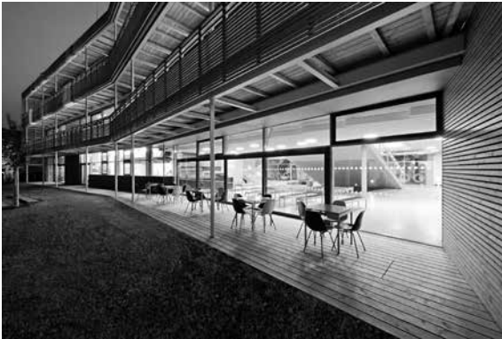
Großzügige Terrasse und Balkone, Foto: Hertha Hurnaus
